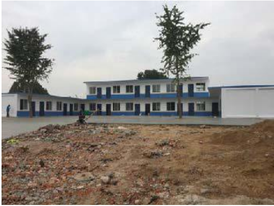
图2-1 站址北侧28m煤矿办公楼
