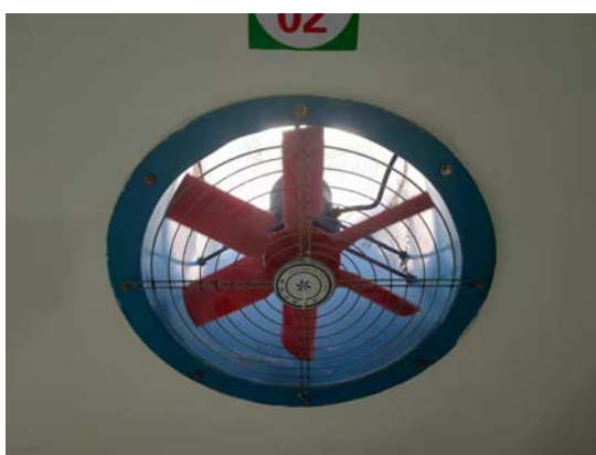
图 6-4 110kV GIS 室排风扇
