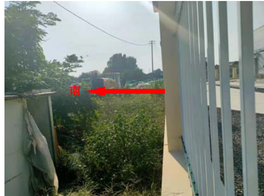
图 4-4 三郭 110kV 变电站南侧
