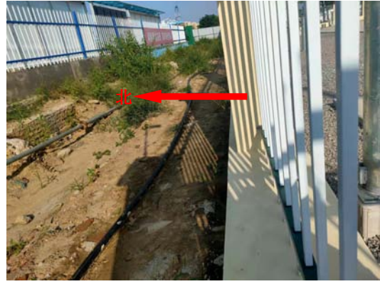
图 4-6 三郭 110kV 变电站北侧
