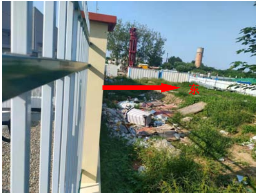
图 4-3 三郭 110kV 变电站东侧(东侧建筑垃圾为共青团路道路施工造成)
