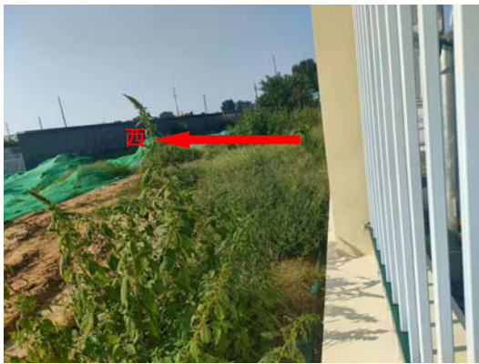
图 4-5 三郭 110kV 变电站西侧
