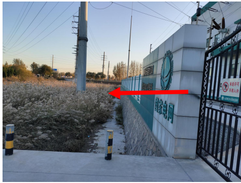
图 4-3 泰达 1100kV 变电站东侧
