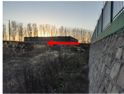
图 4-6 泰达 1100kV 变电站南侧
