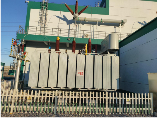
图 4-7 3#主变压器
