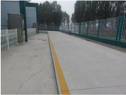
图6-3 变电站内路面硬化
