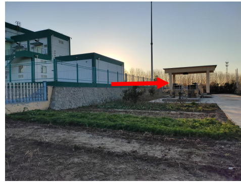
图 4-4 泰达 1100kV 变电站北侧
