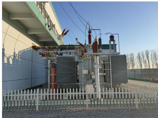
图6-6 3#主变贮油坑
