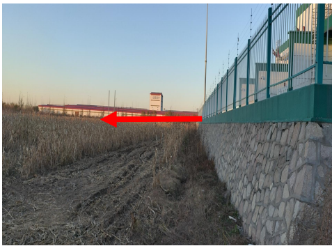
图 4-5 泰达 1100kV 变电站西侧
