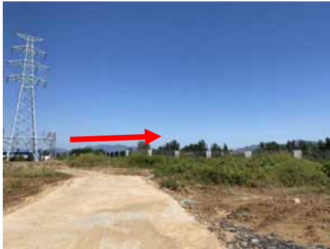
图 4-3 韩家 110kV 变电站东侧
