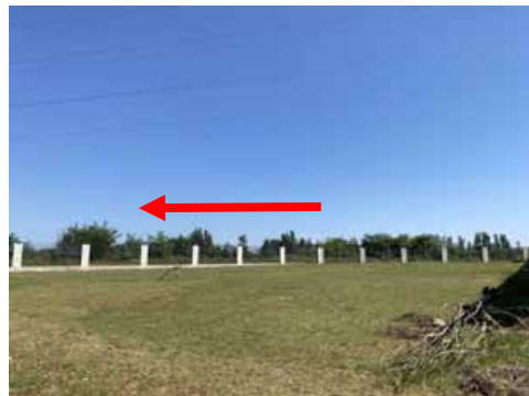
图 4-6 韩家 110kV 变电站北侧
