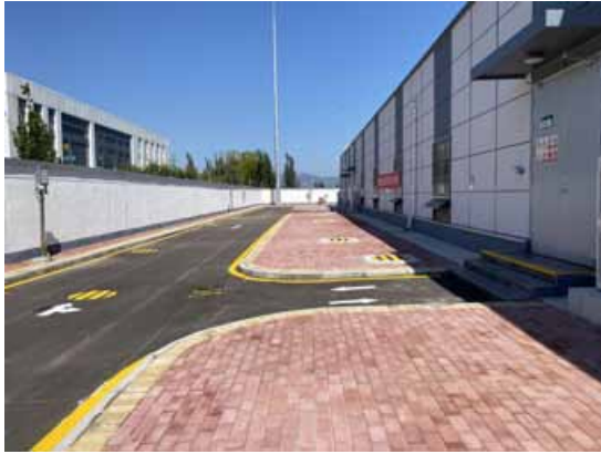
图6-3 变电站内路面硬化
