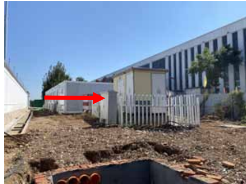
图 4-4 韩家 110kV 变电站南侧
