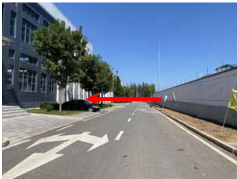
图 4-5 韩家 110kV 变电站西侧
