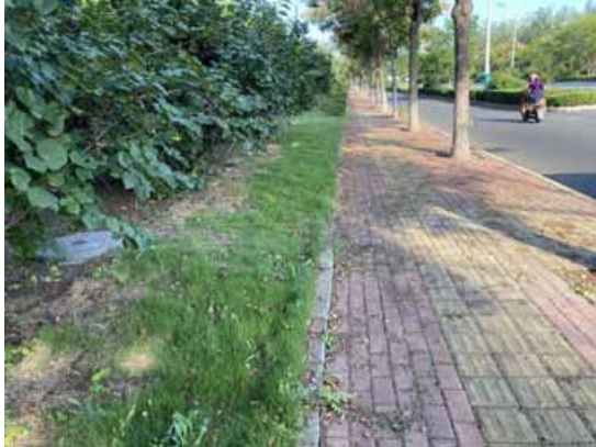
图6-7 电缆沟周围恢复情况
