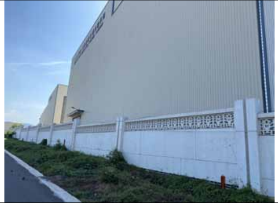
图 2-20 110kV 照旭线/110kV 照韩线线南 1m 山东伊巴米亚数码机械制造有限公司
