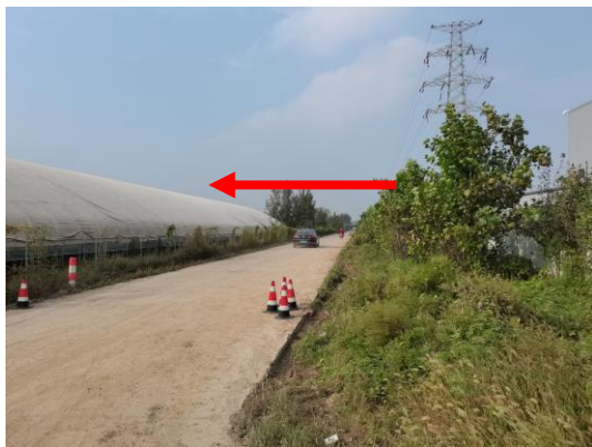
图 4-5 花园 110kV 变电站西侧
