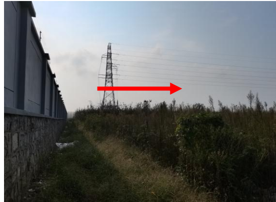
图 4-6 花园 110kV 变电站北侧
