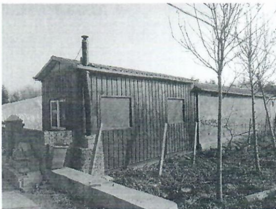
图 2-5 110kV 蓝村甲线 14-2#至 14-3#线南 18m 苗圃看护房
