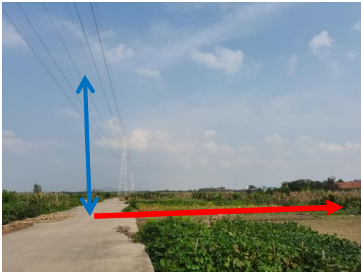
图 7-1 110kV 蓝村甲线 14-14# 至 14-15#之间，向南侧衰减
