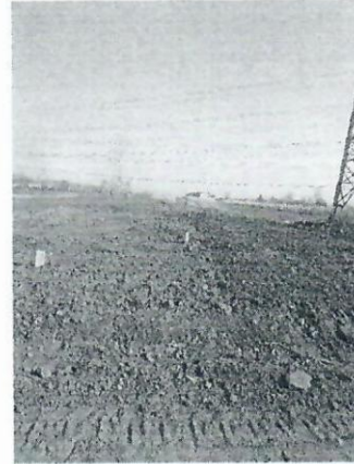
图 2-8 110kV 蓝村甲线与 110kV 蓝村乙线双回电缆沟上方
