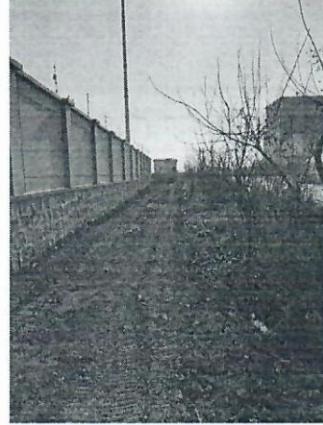
图 1-4 山东青岛即墨花园 110kV 变电站西侧
