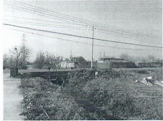
图 2-2 110kV 蓝村甲线 14-14#至 14-15#线北 9m 养殖场看护房
