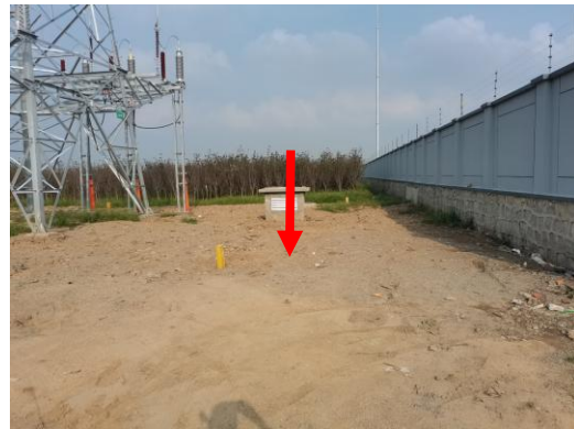
图 7-4 110kV 蓝村甲线 14-22#至花园站之间电缆沟上方
