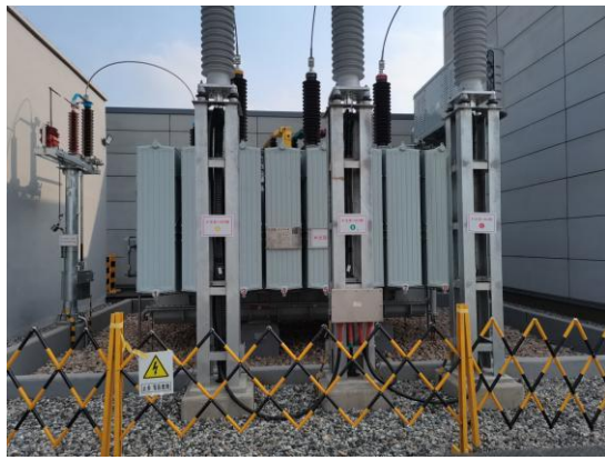
图 4-7 1#主变压器
