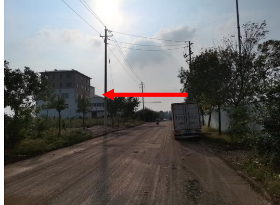
图 4-4 花园 110kV 变电站南侧
