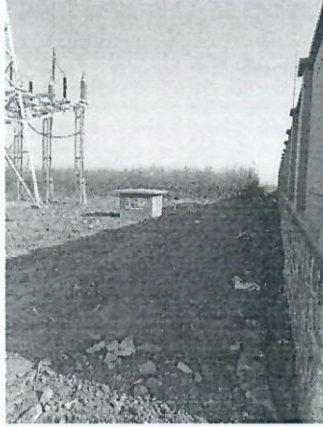
图 1-1 山东青岛即墨花园 110kV 变电站北侧
