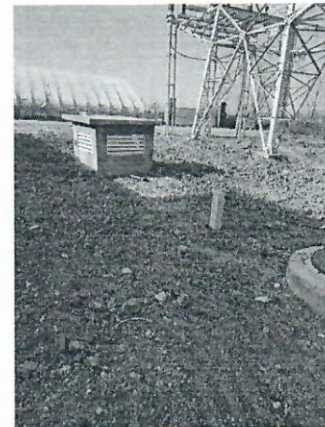
图 2-10 110kV 蓝村甲线与 110kV 山园线双回电缆沟上方
