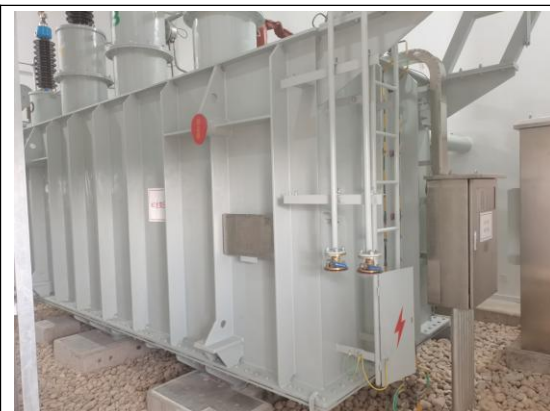
图 4-8 2#主变压器
