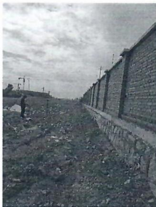
图 3 赵家岭 110kV 变电站站址南侧
