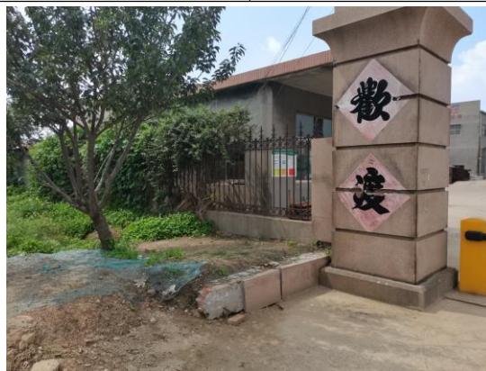
图 2-5 电缆西侧 3m 天山二路西侧旭锐丰门卫
