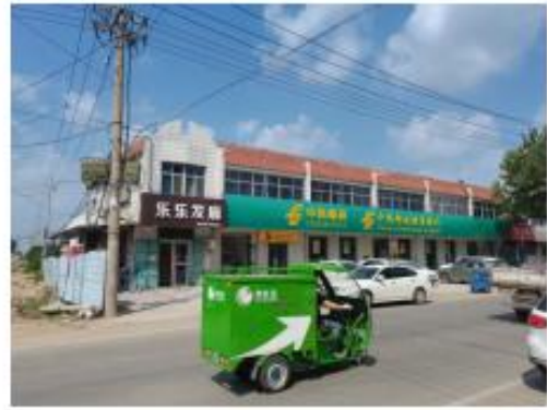
电缆北侧 2m 城马路西侧沿街商铺
