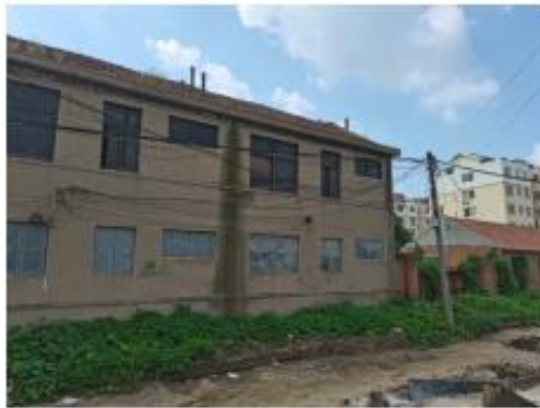
电缆南侧 4m 城马路西侧办公房
