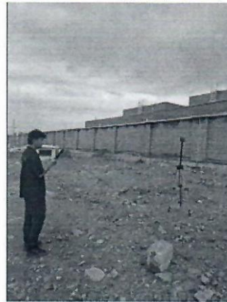
图 4 赵家岭 110kV 变电站站址西侧
