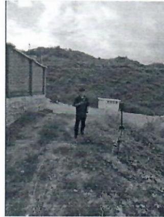
图 2 赵家岭 110kV 变电站站址北侧
