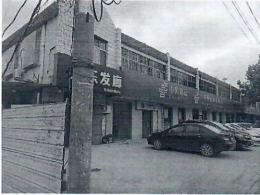
图 7 110kV 广夏线沿街商铺
