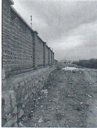
图 1 赵家岭 110kV 变电站站址东侧
