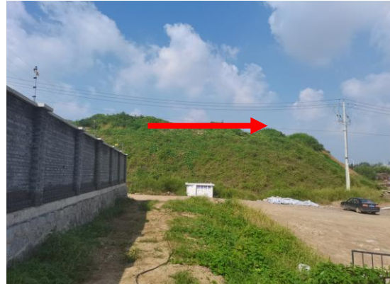
图 4-6 赵家岭 110kV 变电站北侧
