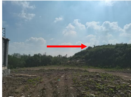
图 4-4 赵家岭 110kV 变电站南侧
