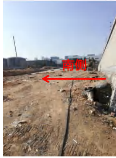
图 4-4 星火 220kV 变电站南侧
