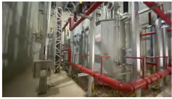
图 4-8 2#主变压器
