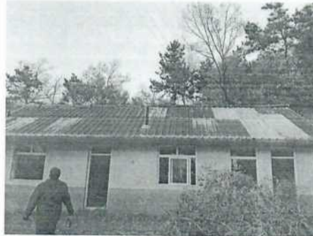
图 3-2 220kV 琅星 II 线 29#-30#线东 13m 喜鹊山西侧闲置房屋
