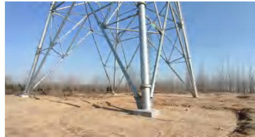
图6-10 靠近茂隆山茂隆山片区土壤保持生态保护红线区塔基处土地平整（琅星 II 线15#）
