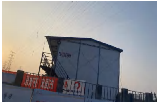
图 2-2 琅星 II 线 55-56#线下规划路 (珠宋路) 西侧在建工地临建房
