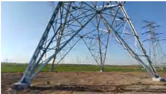
图6-11 穿越小珠山水库饮用水水源准保护区塔基处土地平整1（琅星 II 线25#）
