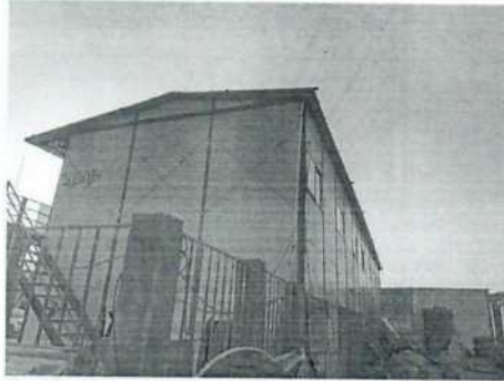
图 3-1 220kV 琅星 II 线 55#-56#线规划路（珠宋路）西侧在建工地临建房
