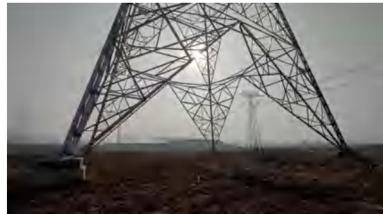
图6-12 穿越小珠山水库饮用水水源准保护区塔基处土地平整2（琅星 II 线32#）
