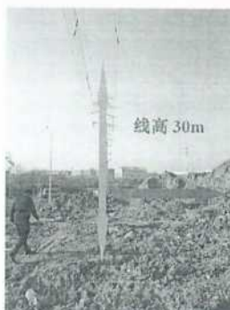
图 2-2 衰减断面②: 220kV 琅星 I 线 57#-58#/220kV 珠星线 57#-58#, 向北侧衰减, 线高 30m。
