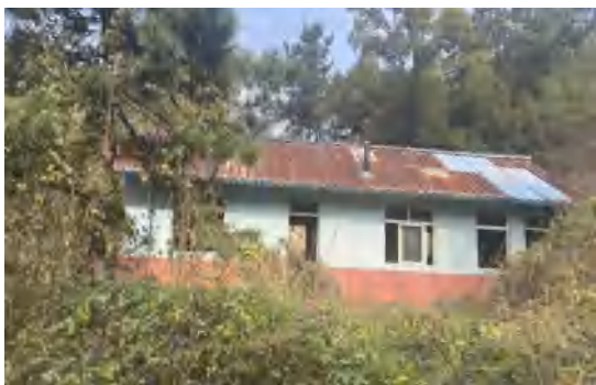
图 2-1 琅星 II 线 29-30#线东 13m 喜鹊山西侧闲置房屋
