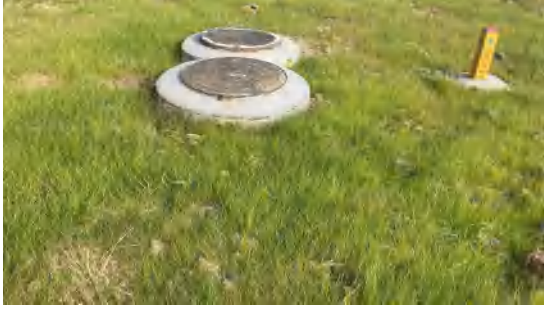
图6-7 电缆沟处植被恢复
