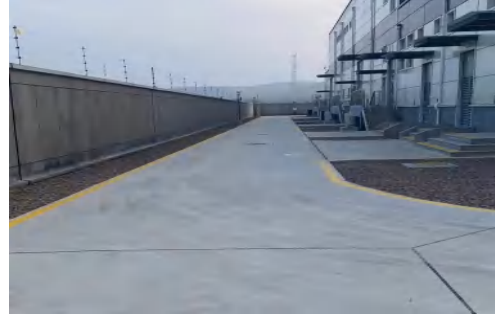
图6-8 变电站内路面硬化
