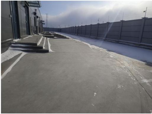
图 6-5 变电站内路面硬化
