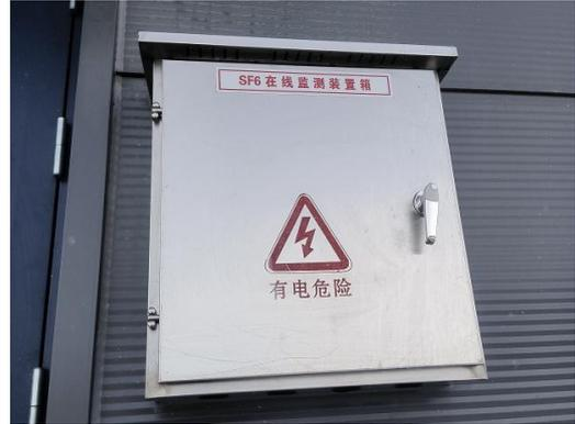
图 6-6 SF6 气体泄漏报警仪
