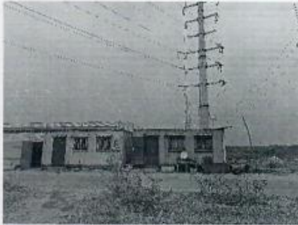
图 7 110kV 江香线 1#~2#、110kV 江盐线 1#~2#线下, 板房
