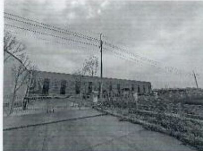
图 2 110kV 江香线 10#~11#、110kV 江盐线 10#~11# 线南 13m, 冀凯装备有限公司北侧厂房
