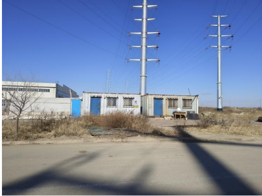
图 2-1 110kV 江香线 1#~2#、110kV 江盐线 1#~2#线下，板房
