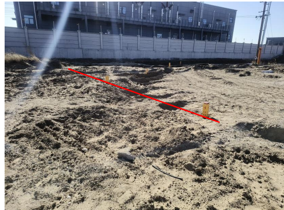
图 6-2 电缆沟周边恢复
