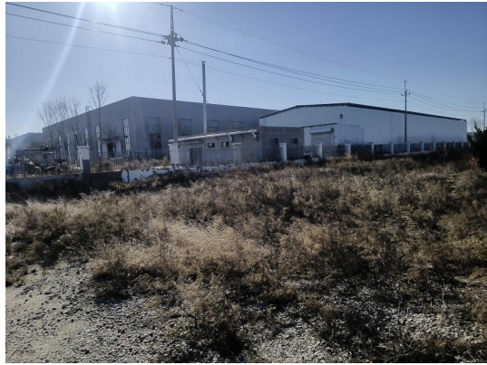
图 2-3 110kV 江香线 10#~11#、110kV 江盐线 10#~11#线南 13m，冀凯装备有限公司北侧厂房
