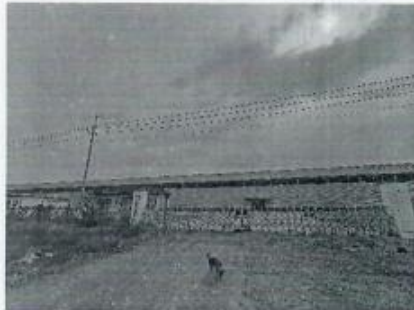
图 3 110kV 江香线 12#~13#、110kV 江盐线 12#~13# 线南 13m, 山东汇强环境装备科技有限公司北侧门卫
