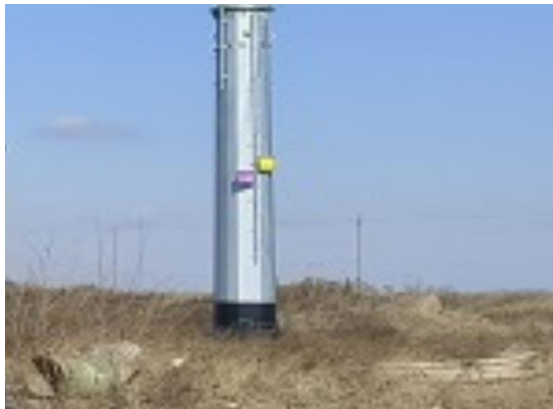
图 6-1 塔基周边恢复
