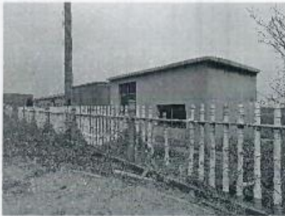
图 5 110kV 江新线 11#~12#、110kV 江新 II 线 11#~12#线北 13m, 山东海翔游艇有限公司西南侧废弃房屋
