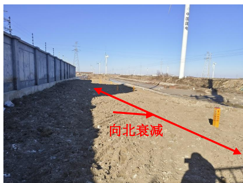
图 7-5 110kV 南森线/110kV 南蔡线双回电缆线路
