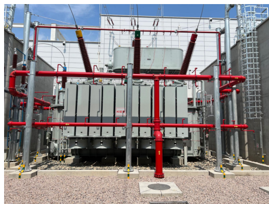
图4-8 #2主变压器（户外）
