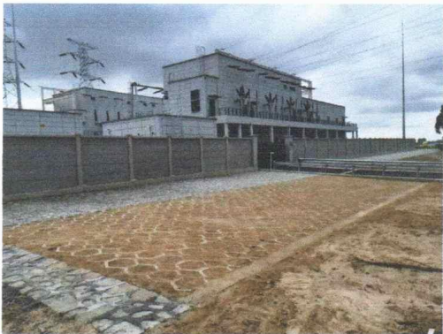
项目现场照片
