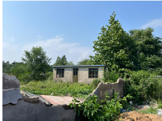
图2-2 220kV 昆召 I 线 037 号 -038 号 /220kV 昆召 II 线 037 号 -038 号 西侧 11m，十里头村民房
