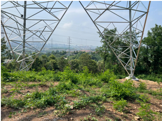
图 6-6 220kV 威召线 110 号/正召线 062 号塔基下方土地恢复情况（红线区内）
