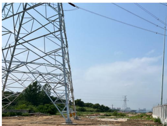
图 6-11 220kV 昆召 I 线/昆召 II 线 038 号塔基下方土地恢复情况（红线区外塔基）
